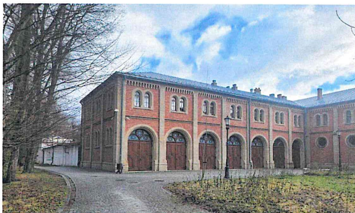
fot. 117 Pszczyna ul. Basztowa 4-8
