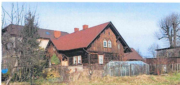
fot. 3 Dom, Poręba, ul. Wodna 13
