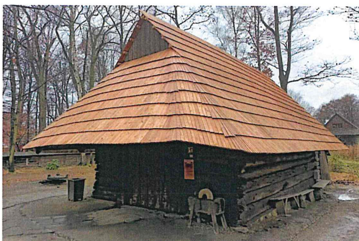
fot. 4 Masztalnia z Wisły Wielkiej, Skansen 5
