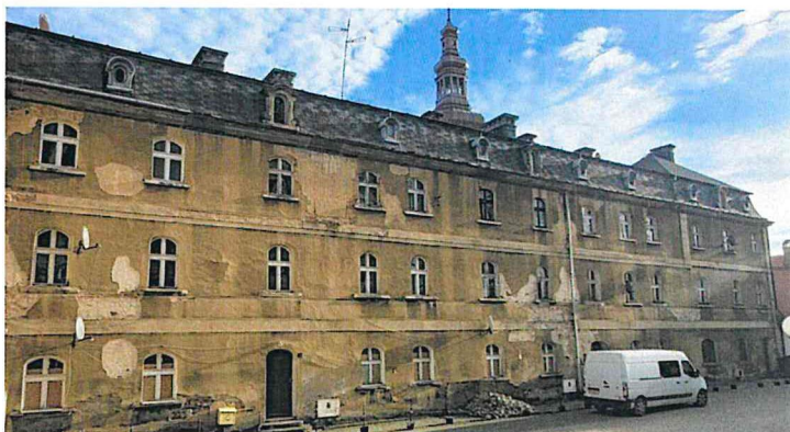
fot. 31 Pszczyna ul. Basztowa 1-7
