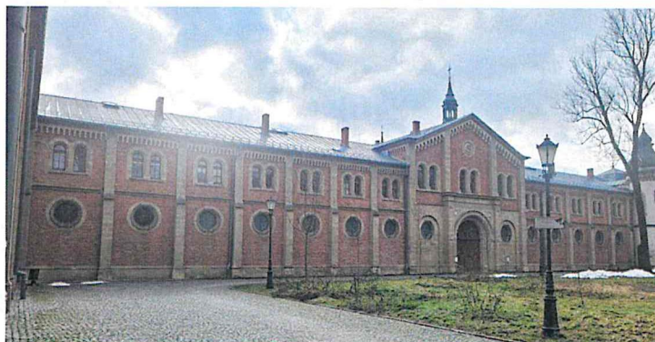
fot. 116 Pszczyna ul. Basztowa 4-8
