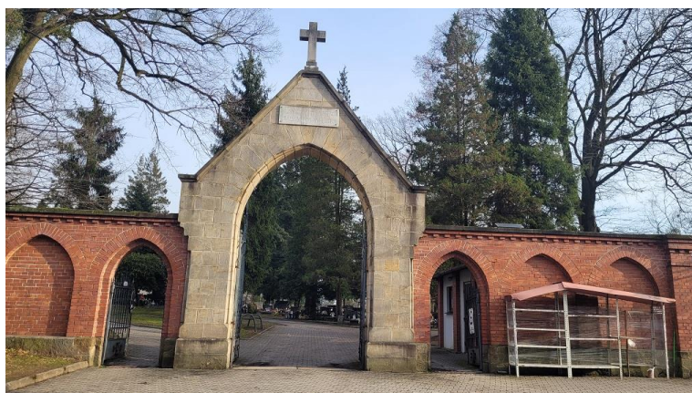
fot. 63 Pszczyna ul. Katowicka
