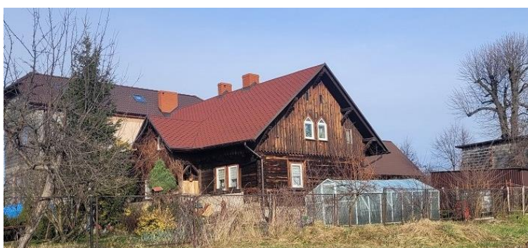
fot. 3 Dom, Poręba, ul. Wodna 13
